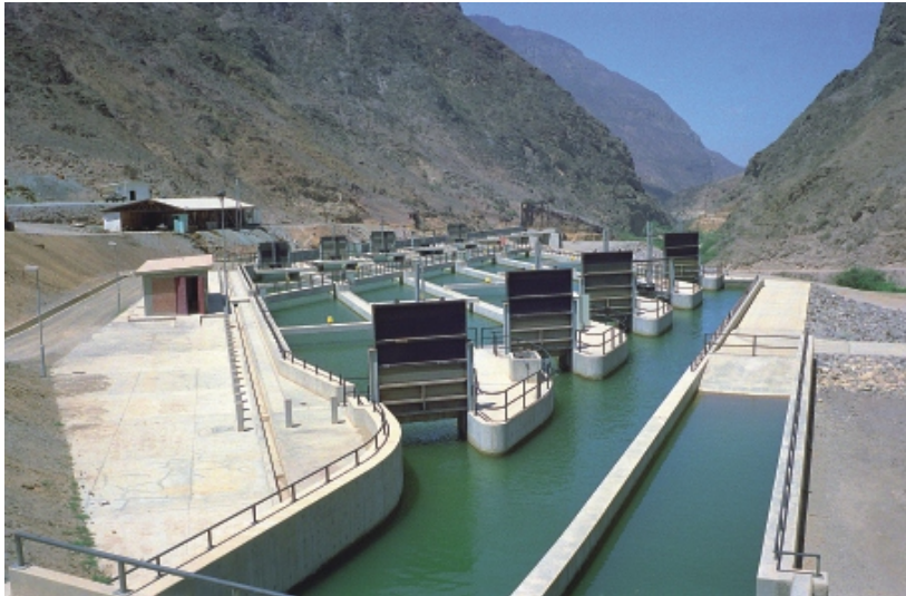
Electro Peru: Carhuaquero Su Alma Yapısı, 1981'den beri işletmede, 30 m uzunluğunda 10 üniteli.
