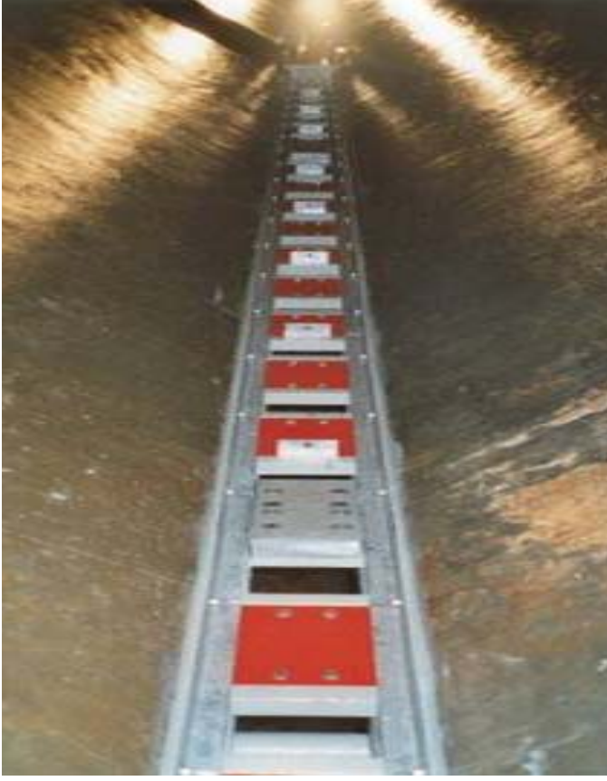
Engadiner Kraftwerke AG Varusch su alma yapısı MOTEC plakalı yeni elemanların montajı
