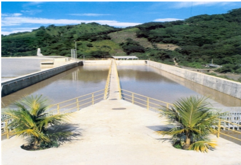
I.N.DE. Guatemala: Aguas Caliente Su alma yapısı, 1977'den beri işletmede, 25 m uzunluğunda 6 üniteli
